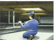
ユニットを外せば点検口に早変わり。人が充分に通れる床開口寸法なので、床下の配管や水漏れなどの点検・修理の際も便利です。
